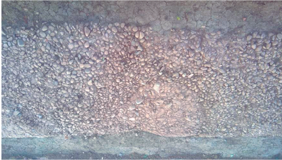
Figura 7. Primera calle de Santa María de la Antigua del Darién 1510- 1524. Fotografía tomada por Cristian Vallejo Romo.
